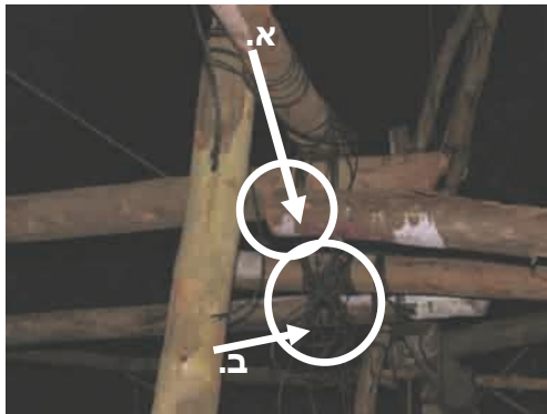
א. הסנאדה שנשלפה מהכפיתה (ללא יתרה של כ-15 ס"מ מקצה הכפיתה) ב. הכפיתה שממנה השתחררה הסנאדה
